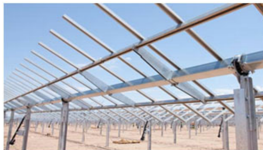
Figura 21. Estrutura metálica de um módulo fotovoltaico
