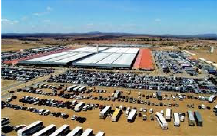
(A) Inaugurado em 2006, o Moda Center de Santa Cruz do Capibaribe recebeu alta valorização positiva de todos os empresários do município ouvidos nas entrevistas e em grupos focais
