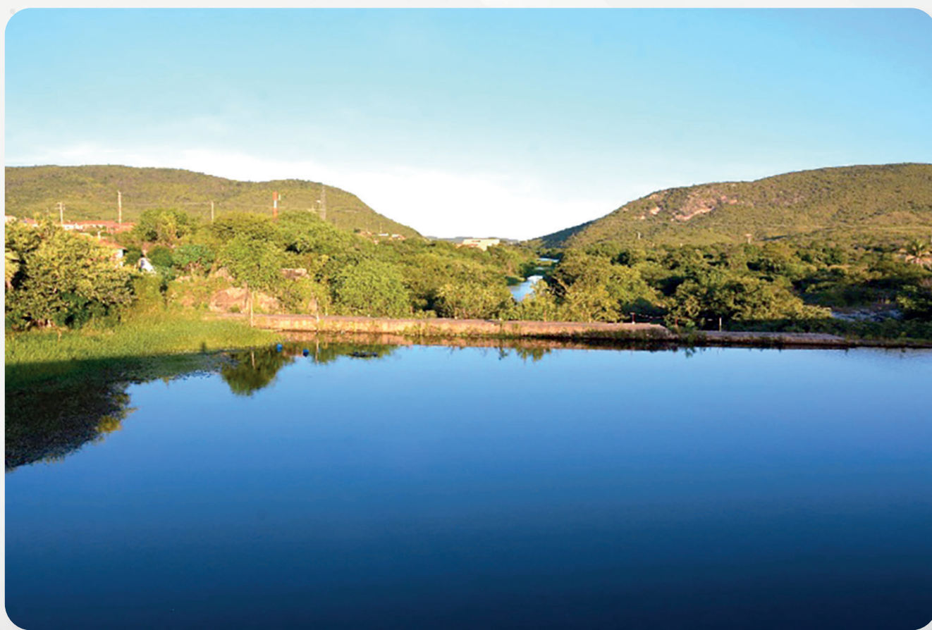
Barragem de Arneiroz na entrada da cidade e do boqueirão formado pela abertura da serra do zumbi que é cortada pelo rio Jaguaribe.
