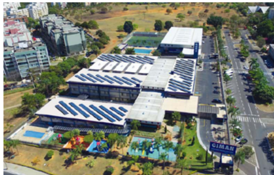
Imagem aérea das placas solares na cobertura do Colégio CIMAN.
