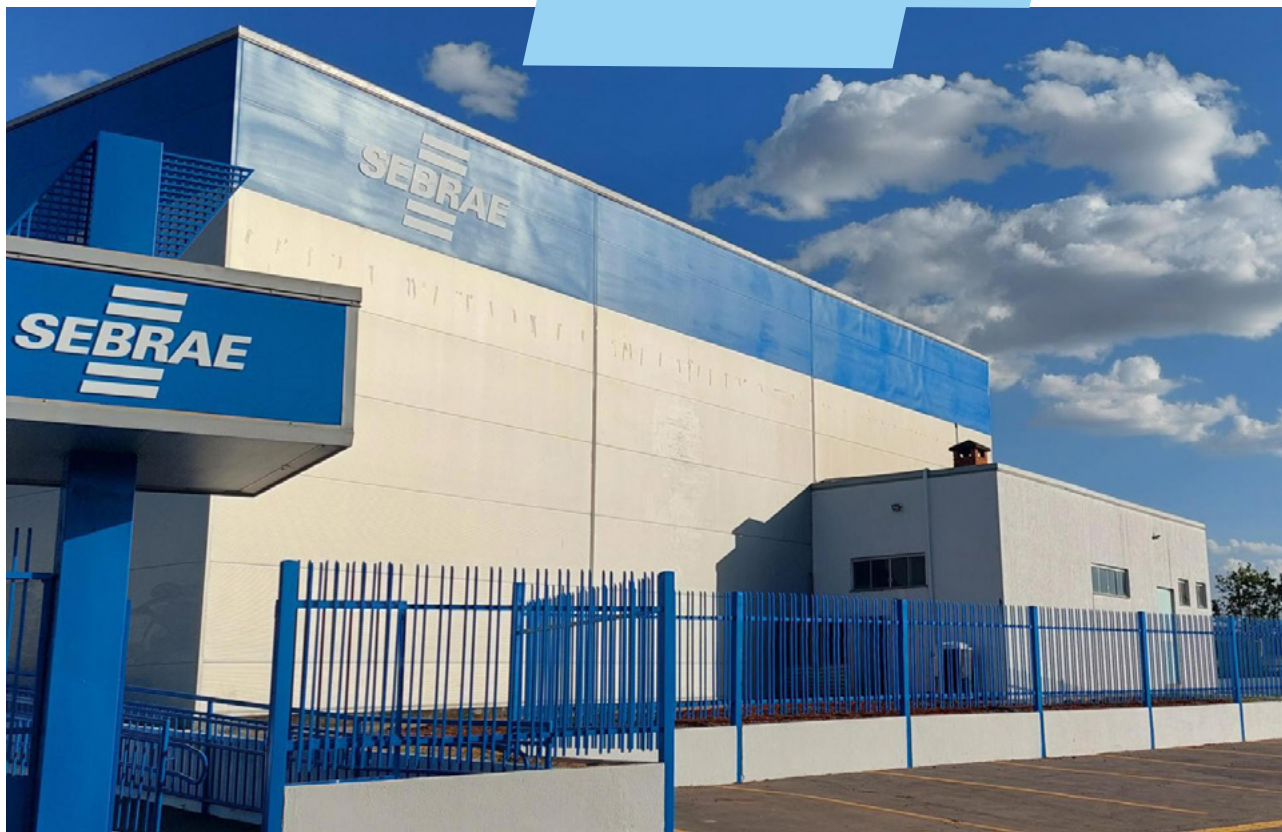
Nova Sede da Regional Metropolitana em Aparecida de Goiânia
