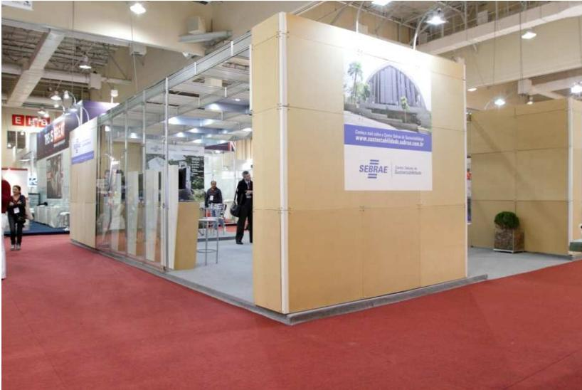
**3.2 Paredes** – Deverá ser montada com sistema de montantes de alumínio anodizado tipo “Octanorm”, unidos por travessas retas de alumínio. A fixação dos painéis devem ser realizada de forma que os pilares não apareçam por fora, isto é, permaneçam no lado interno do estande, e devem ser fixados com suporte para vidro, de forma que confirmam segurança ao conjunto, conforme projeto.
