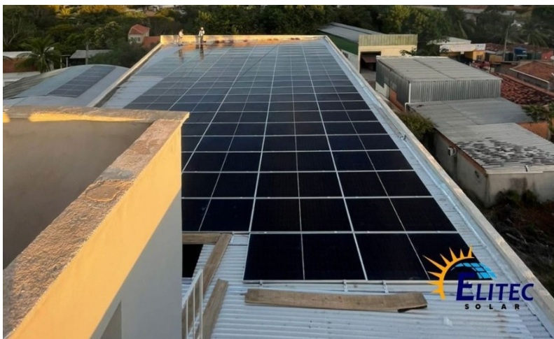
Figura 3: imagem de instalação de painéis solares da empresa Elitec Solar
