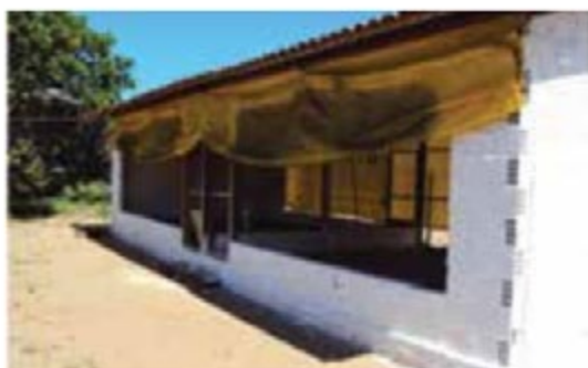
Fig. 11. Aviário de alvenaria com telhas de barro.
