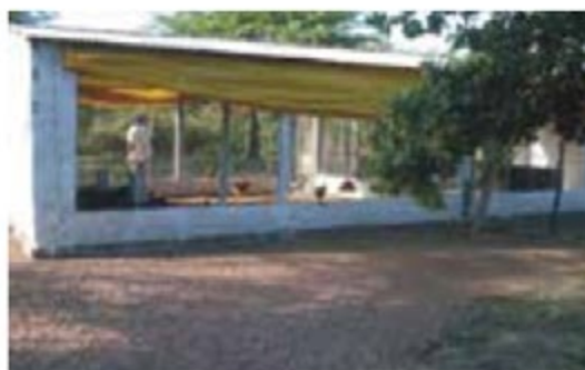
Fig. 12. Aviário de alvenaria com telhas de fibrocimento.
