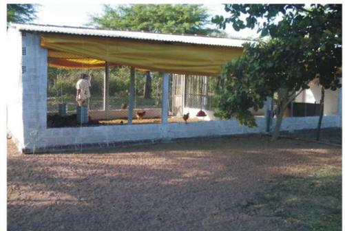
**FIGURA 12 - Aviário de alvenaria com telha de fibrocimento.**
