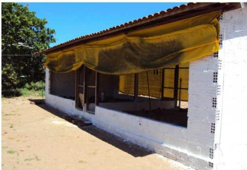
**FIGURA 11 - Aviário de alvenaria com telhas de barro.**
